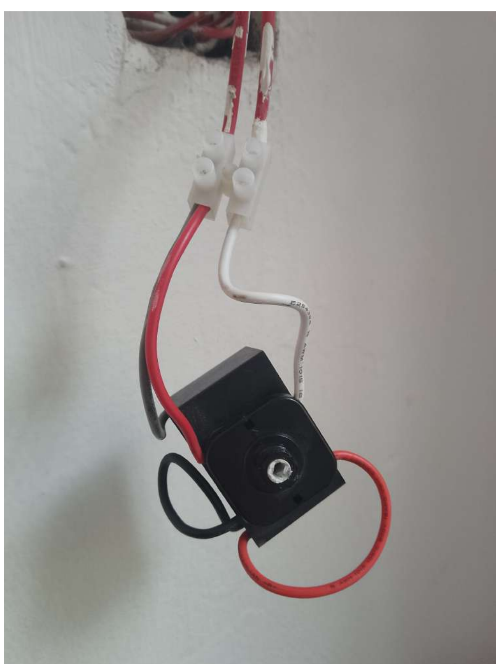
04. Cambio de controles de ventiladores de techo
