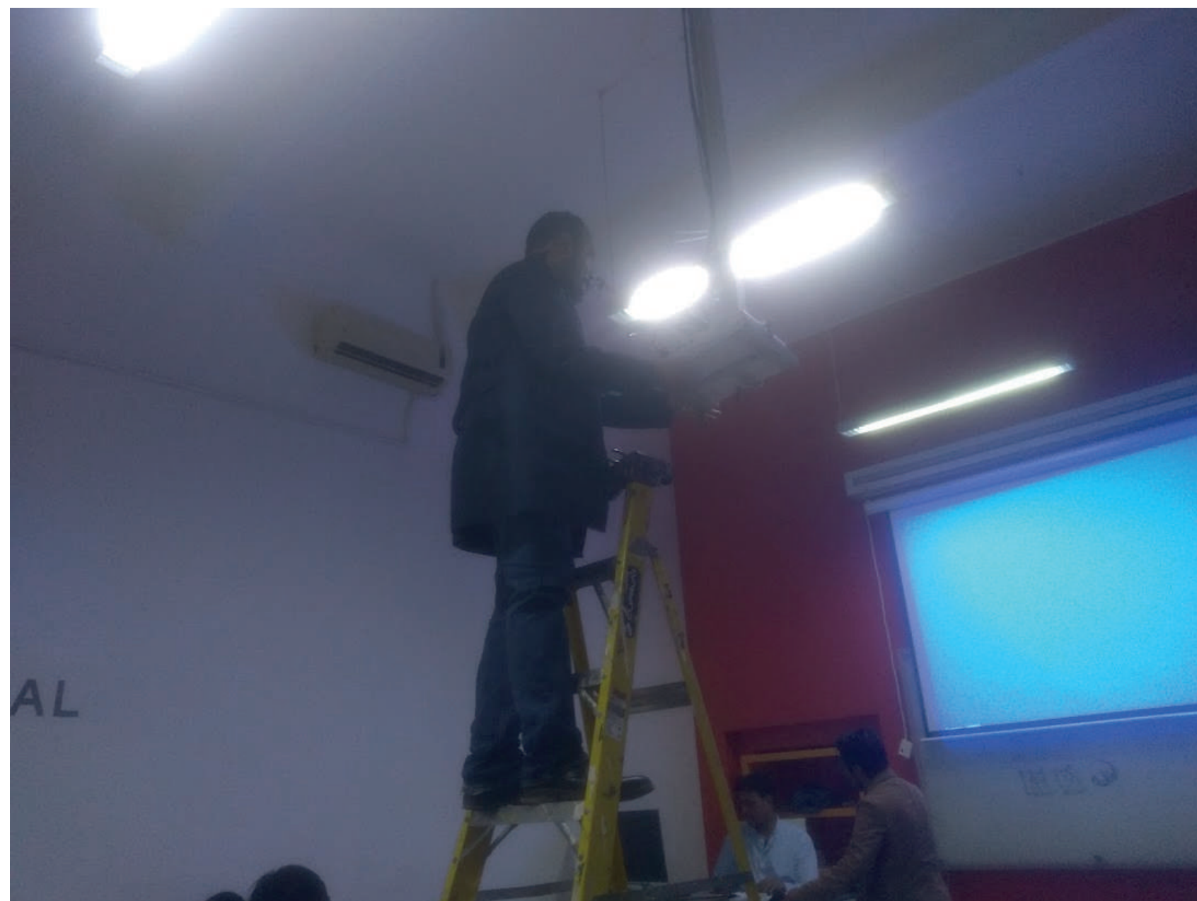
03. Cambio de luminarias talleres
